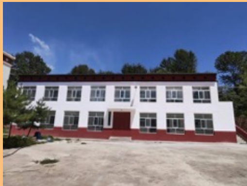
Nach der Renovation
